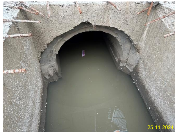
รูปที่ 3-40 การตรวจสอบรางระบายน้ำและการลอกรางระบายน้ำ
